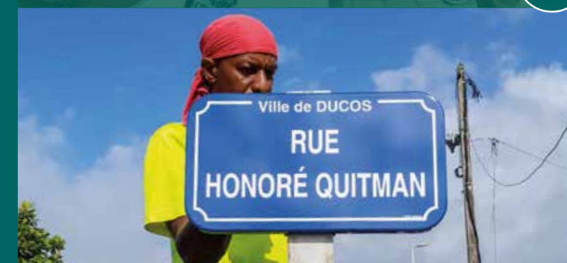
Installation de panneaux par le service technique
